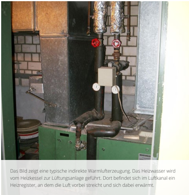
Im Heizungs- bzw. Warmluftkeller findet sich oft solch eine Klappenregelung. Sie zeigt an, mit welchem Umluft- bzw. Frischluft-Anteil die Anlage betrieben wird. Sie sollte in klassischen Kirchen in der Regel auf „100 % Umluft-Betrieb“ stehen.
